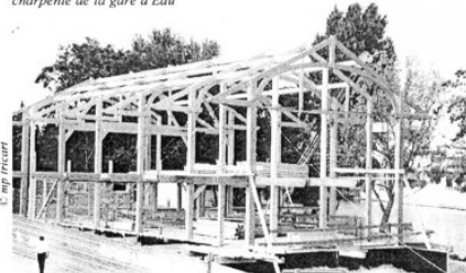
Lulu sera mise à l'eau le jour de la pose du "bouquet" au faitage de la charpente de la gare d'Eau
