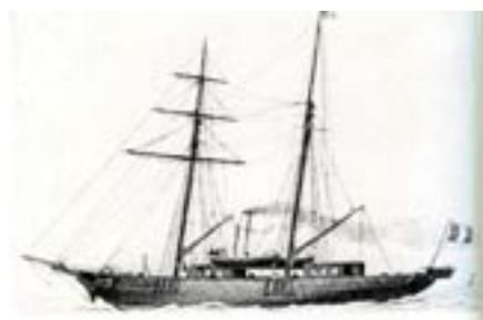
*Fauvette jauge 250 TX pour 38m de longueur hors tout, 6.15m au maître bau, un creux de 3.60m.*
