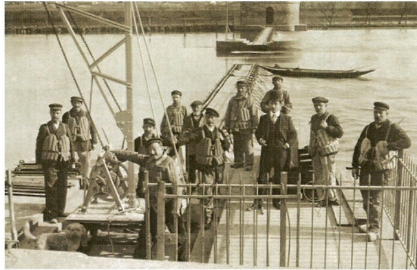
Démontage du barrage en période de crue.
