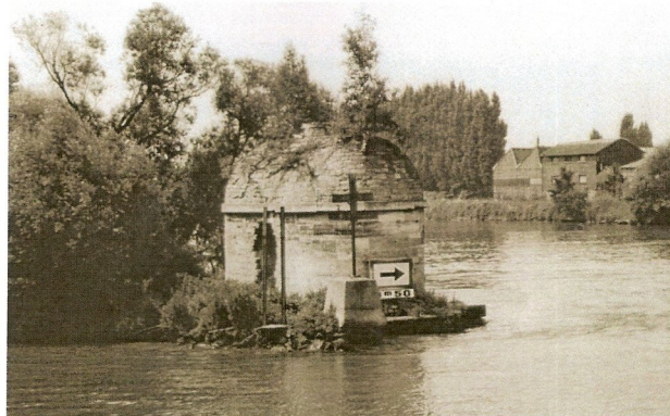
Le petit édicule, vestige du barrage à aiguilles.
