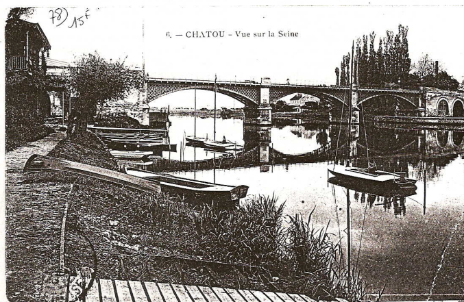
Vue de l'ancien pont routier de Chatou depuis les pontons Fournaise. (coll. Outin)
