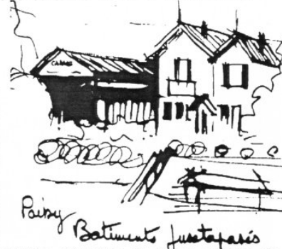
Dernière guinguette de Poissy, exemple de constructions juxtaposées réalisée au fur et à mesure des besoins. Seul le garage est en bois.
